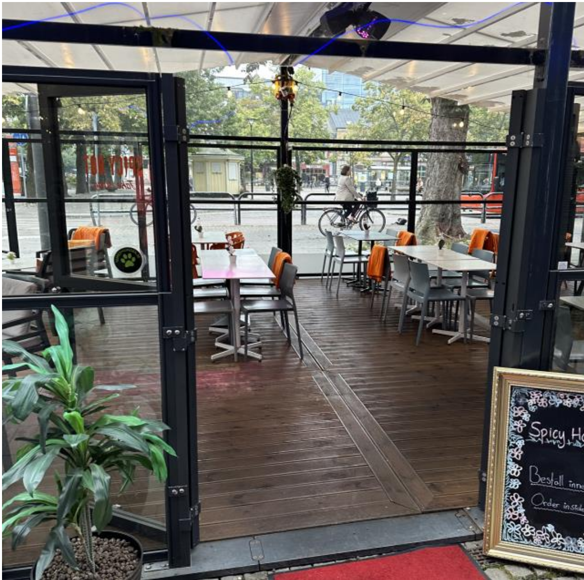
Figur 3. Pardörr inom Spicy Hots servering, uppställd med kilar.
